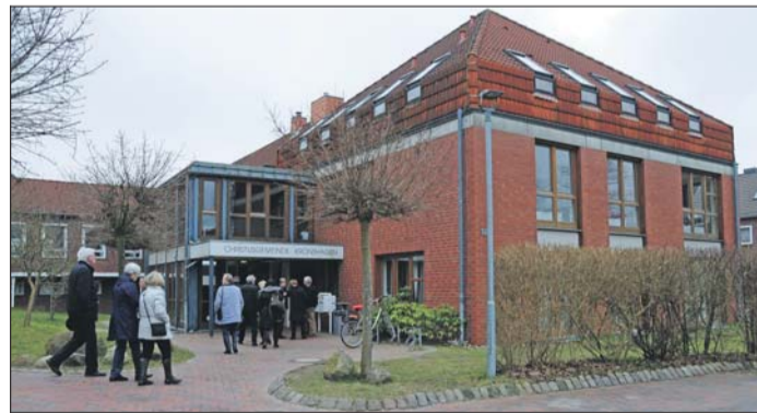
Die Christusgemeinde Kronshagen will ihr Gemeindezentrum verkleinern. Der erst vor 24 Jahren errichtete Anbau soll abgerissen werden, weil die Bausubstanz marode ist und zu viele Räume leer stehen. Foto TM
